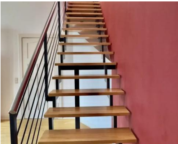
Treppe ins DG
